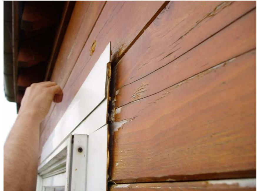
Poussée en tete de mur: assemblage chevron
